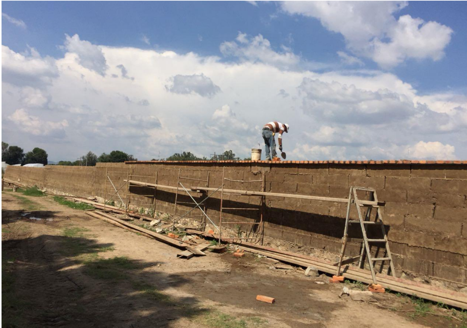
Construcción de la barda perimetral del CUCBA (85% )
